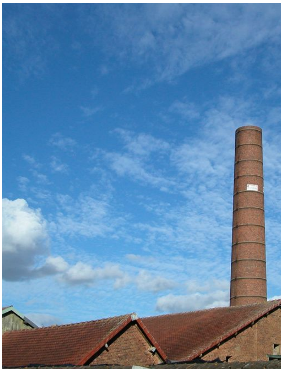
Détail des toitures des ateliers de la salle des machines et la cheminée.
