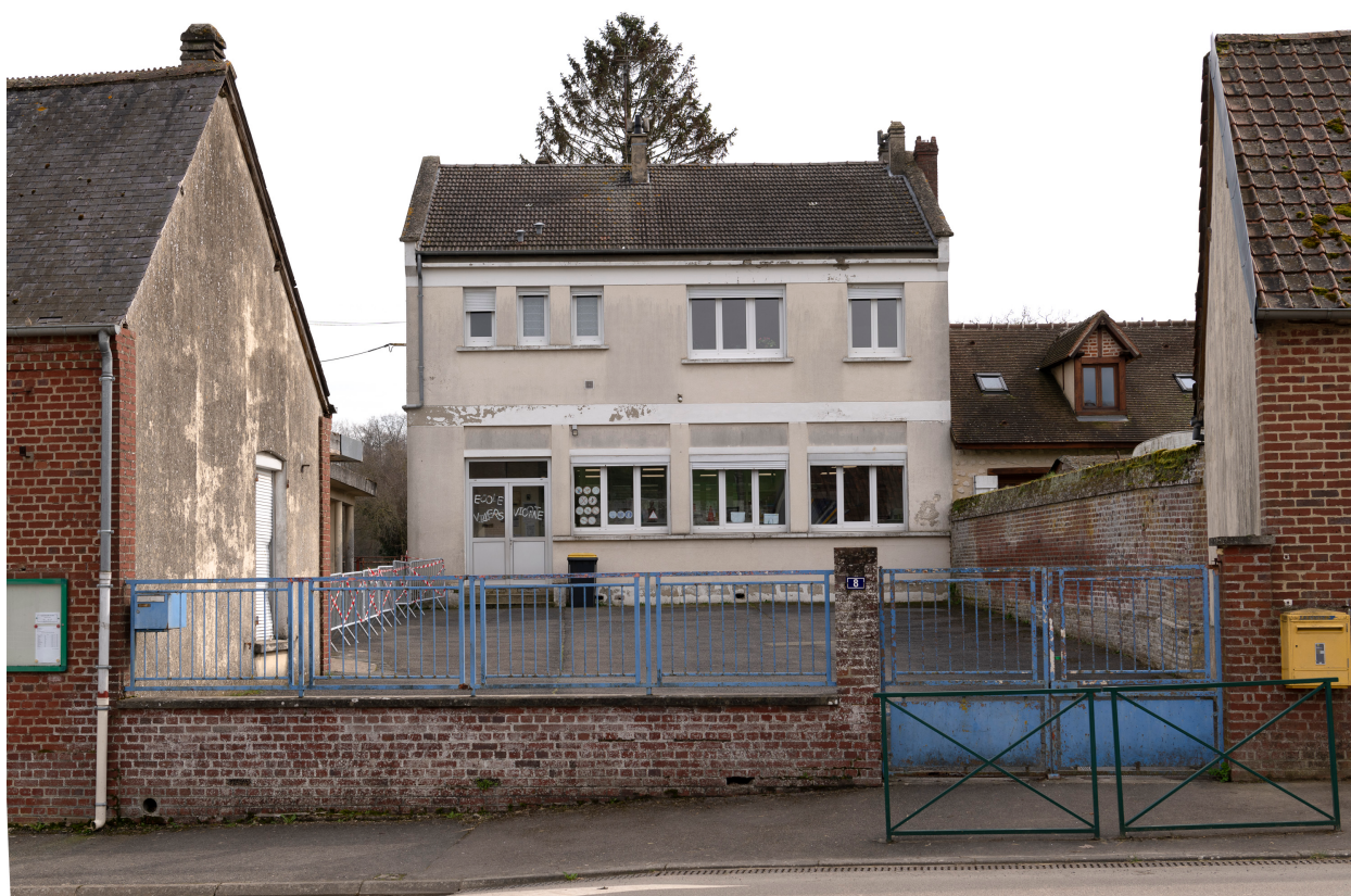
École, vue prise depuis le nord.
