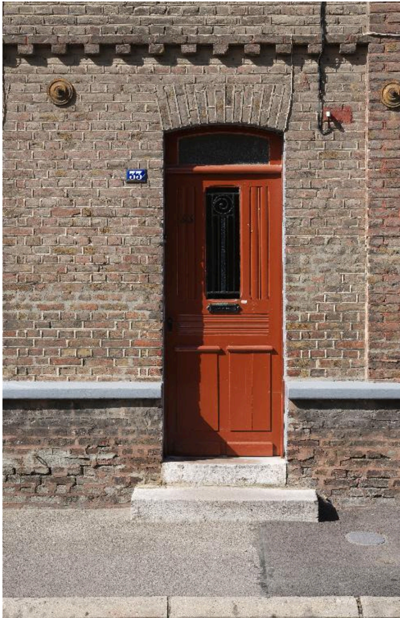
Détail de la porte d'entrée sur rue, 33 rue Léon-Hénocque.
