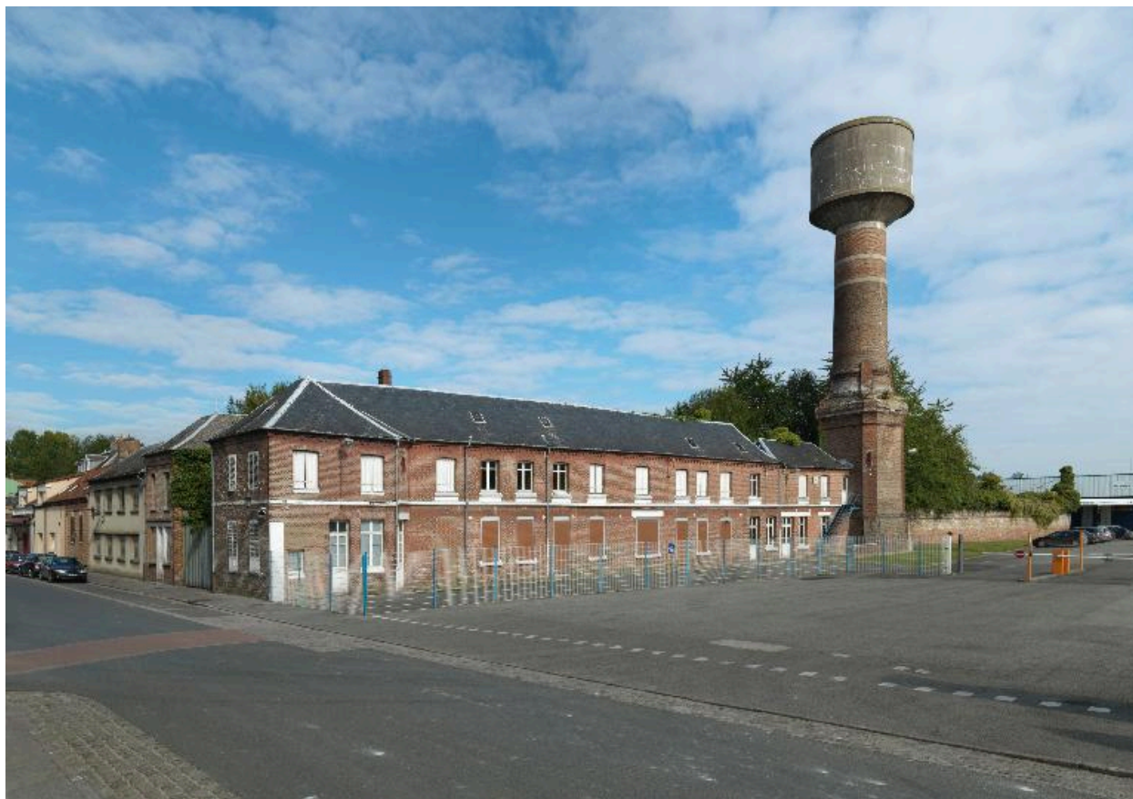
Vue de l'ancienne infirmerie et de l'ancienne cheminée de 1865 attenante.
