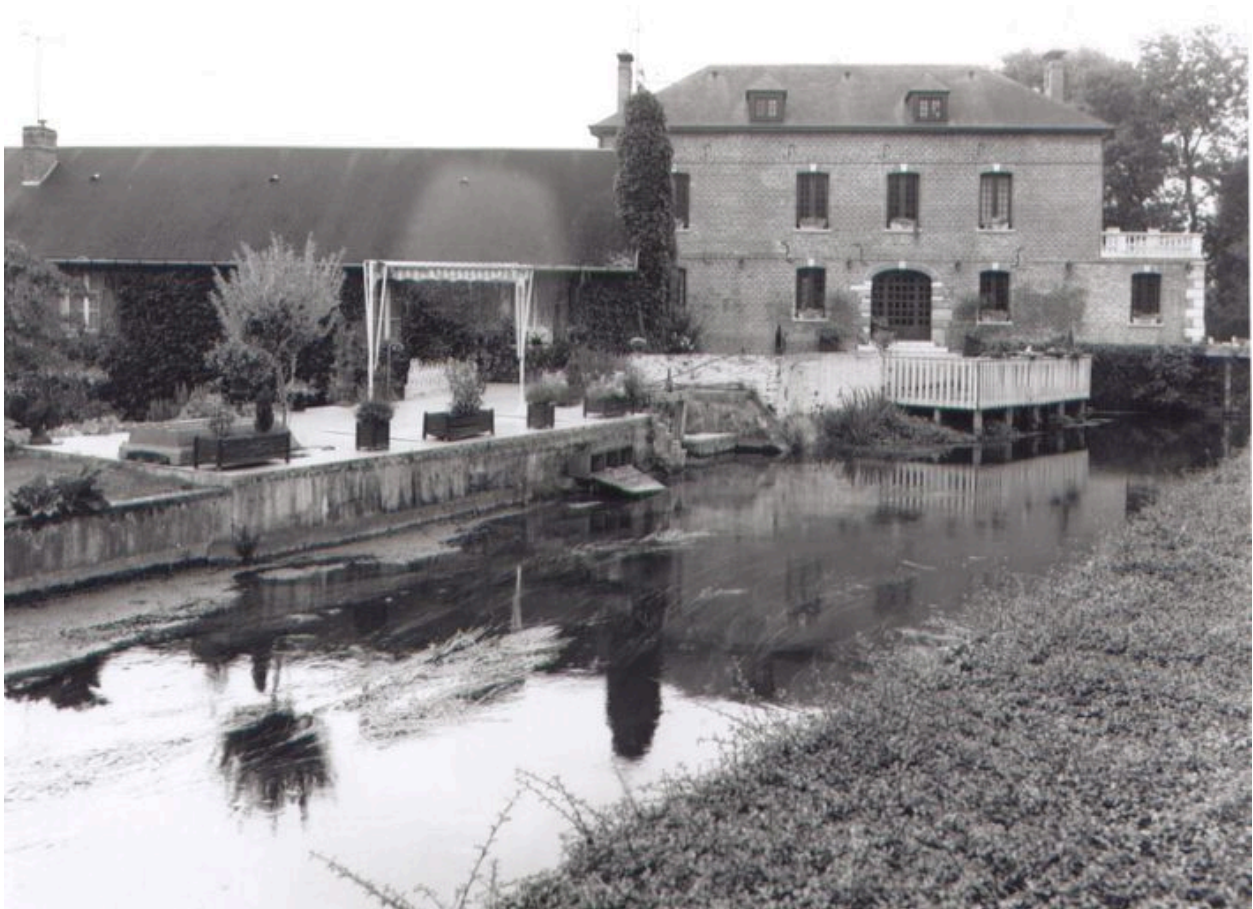
Vue d'ensemble du l'usine, côté ouest.
