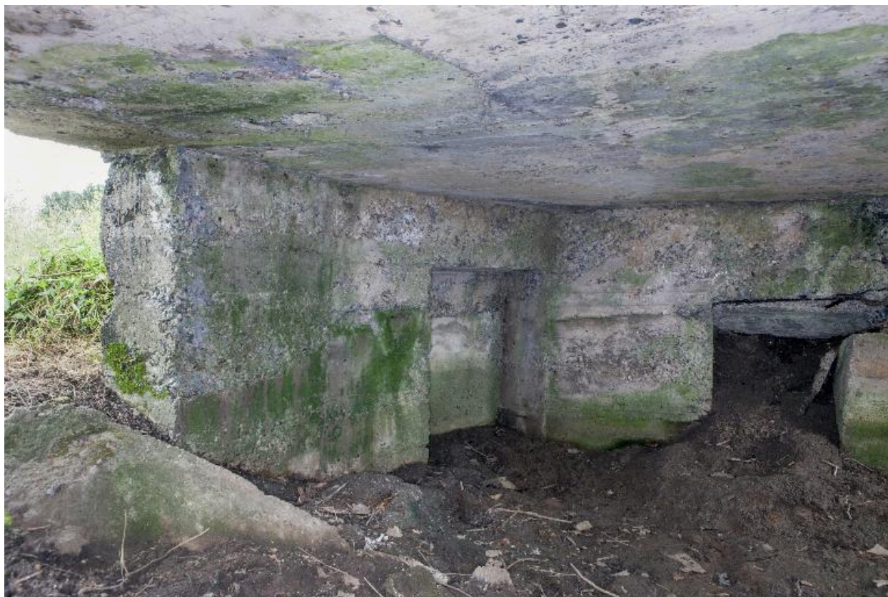
Chambre de tir, vers l'ouest
