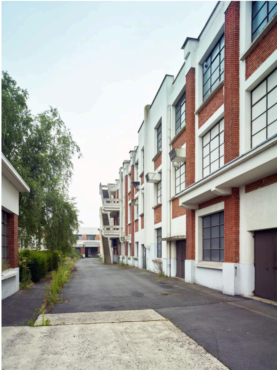
Elévation nord de l'atelier de fabrication (G), vers l'est.
