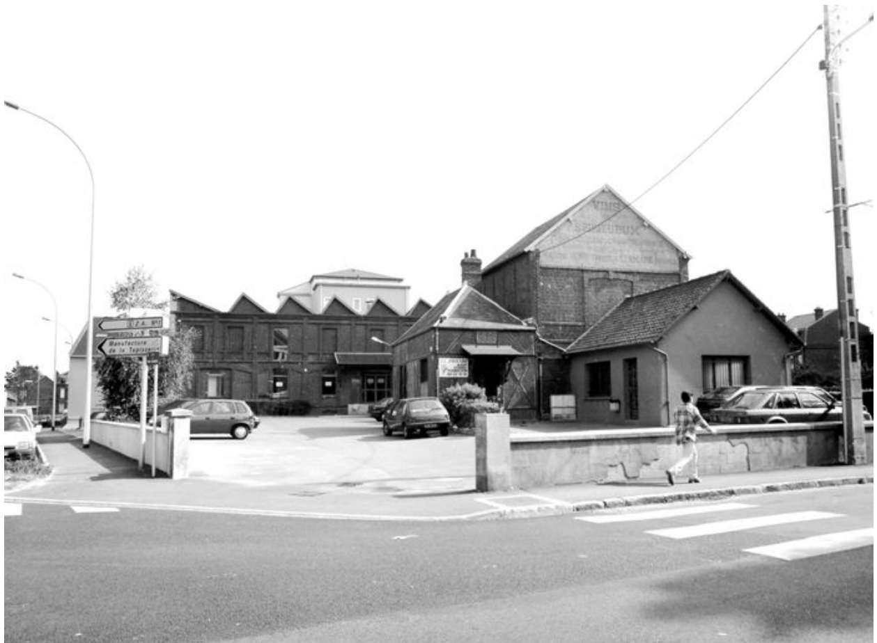
Vue antérieure de l'atelier de fabrication avec sheds.
