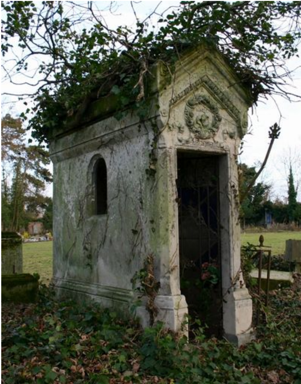
Vue générale, depuis le côté.
