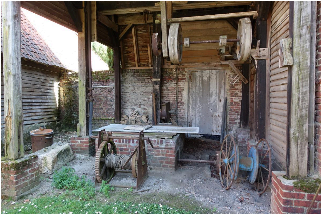
Détail du mécanisme de pompage du puits.
