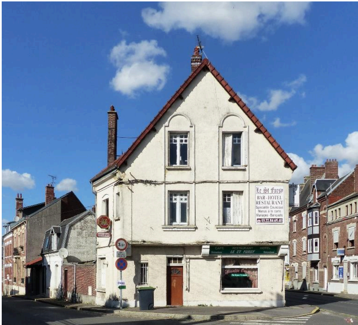
Vue de la façade sud.
