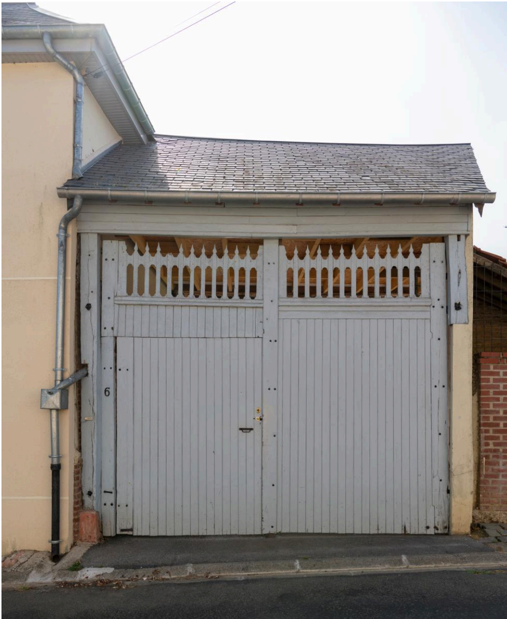
Entrée charretière, n°6 rue Marcel Dassault, vue depuis le nord.
