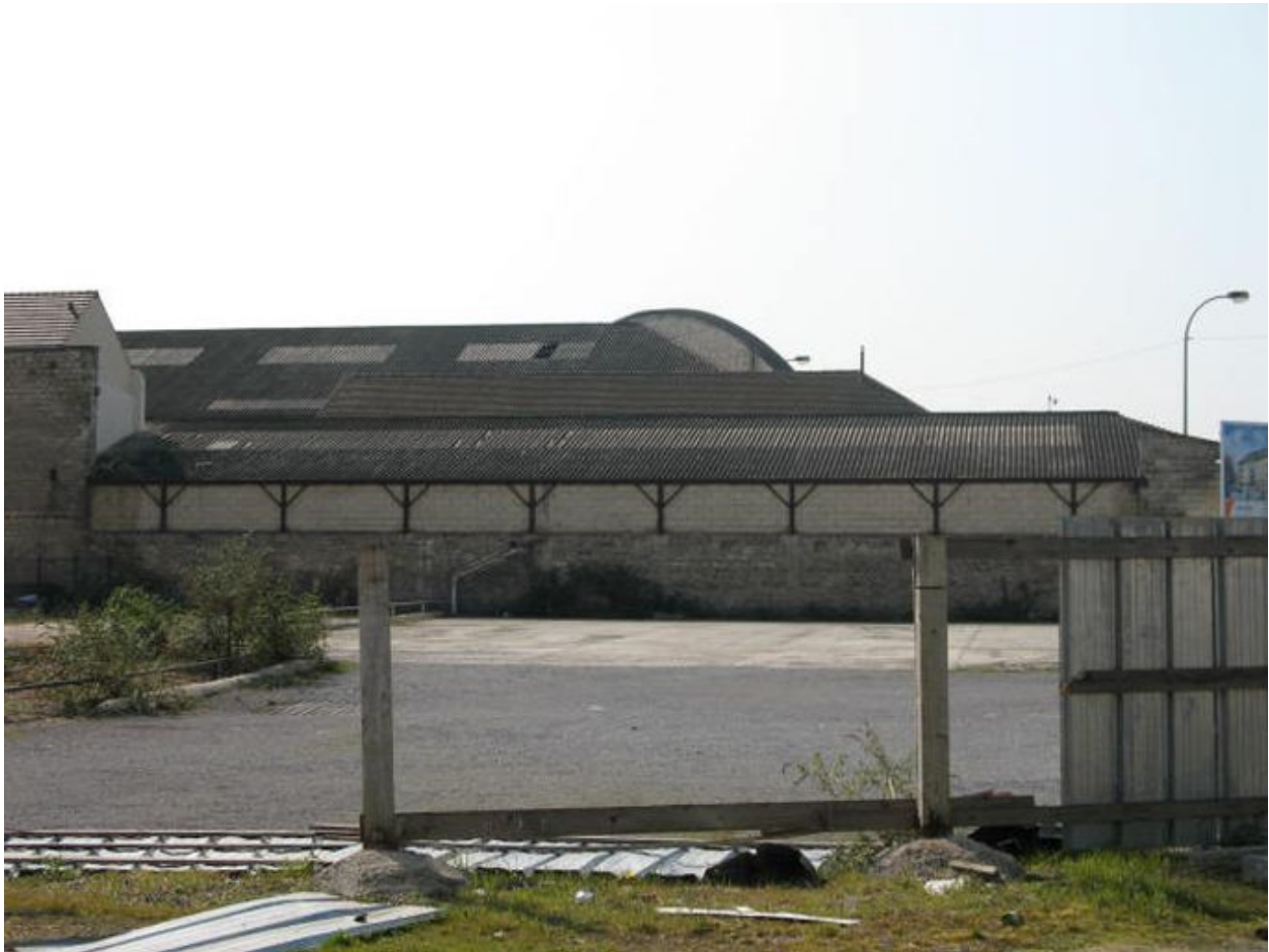
Succession de toitures des entrepôts Boufflette.
