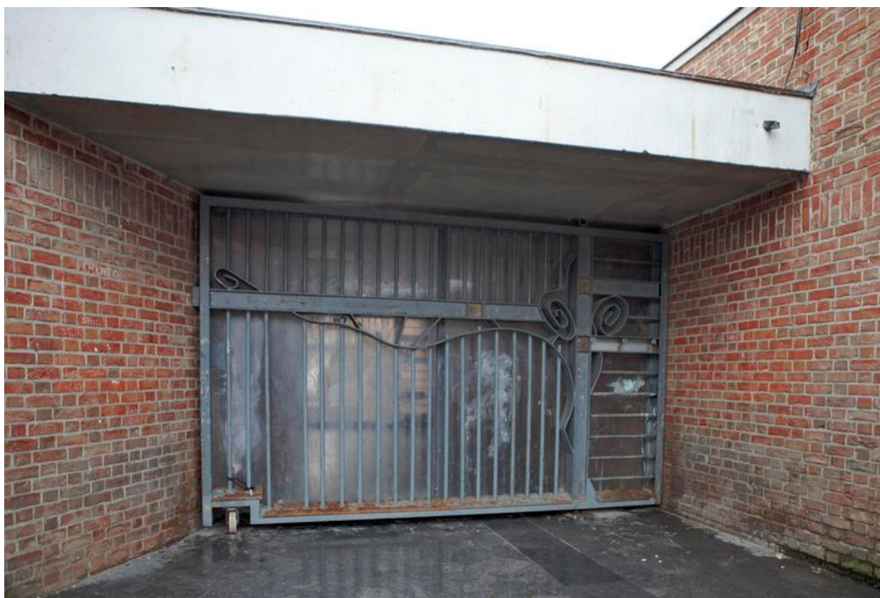
Détail de la porte.
