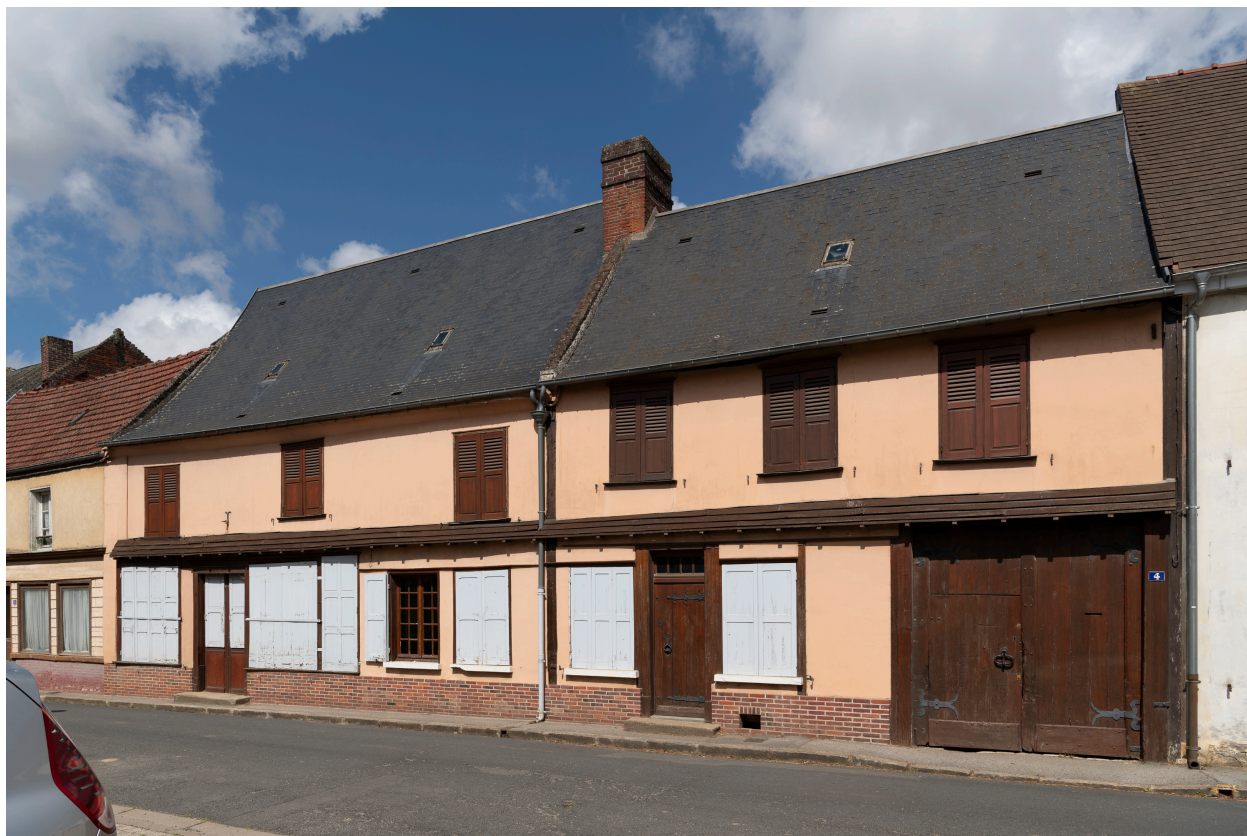
Anciens magasins de commerce, n°4 de la rue de la Halle, vue depuis le sud.
