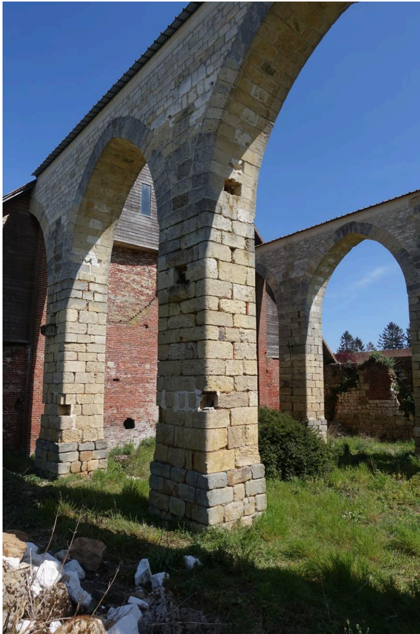
Vue rapprochée depuis le nord-ouest : piliers et arcades.
