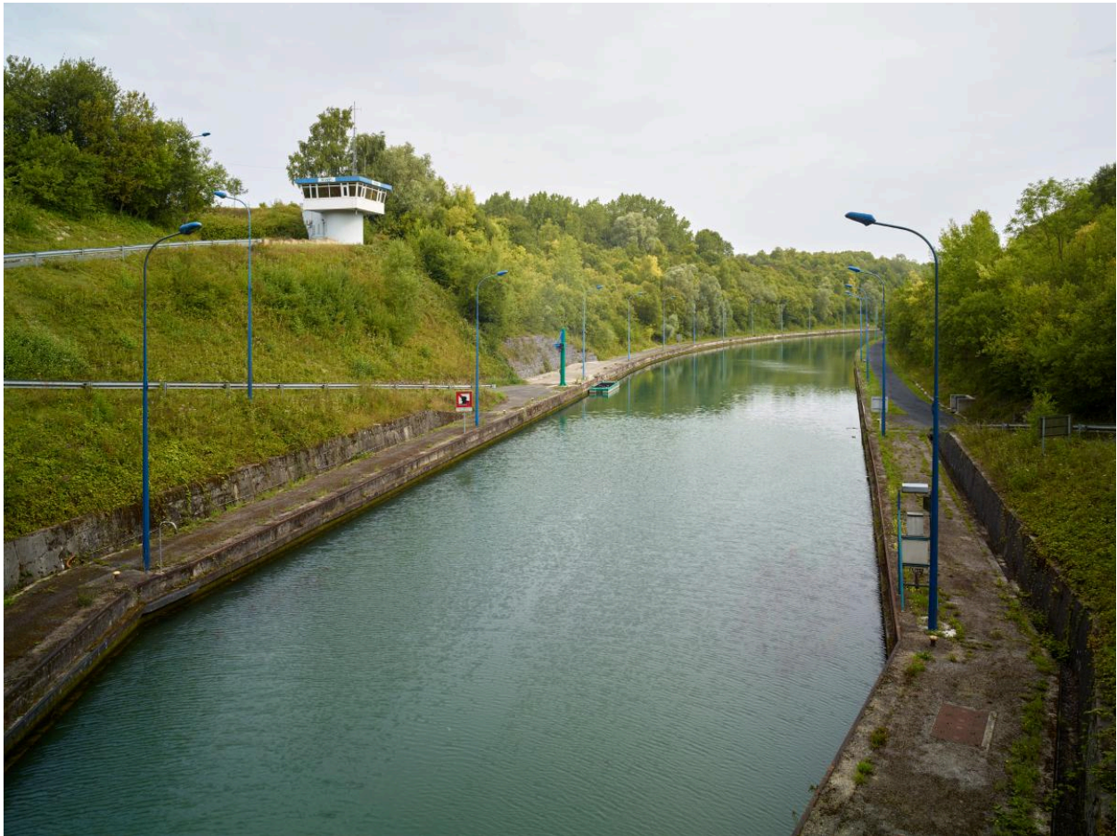
Vue depuis la tête nord. Poste de commande et quai de stationnement des péniches.
