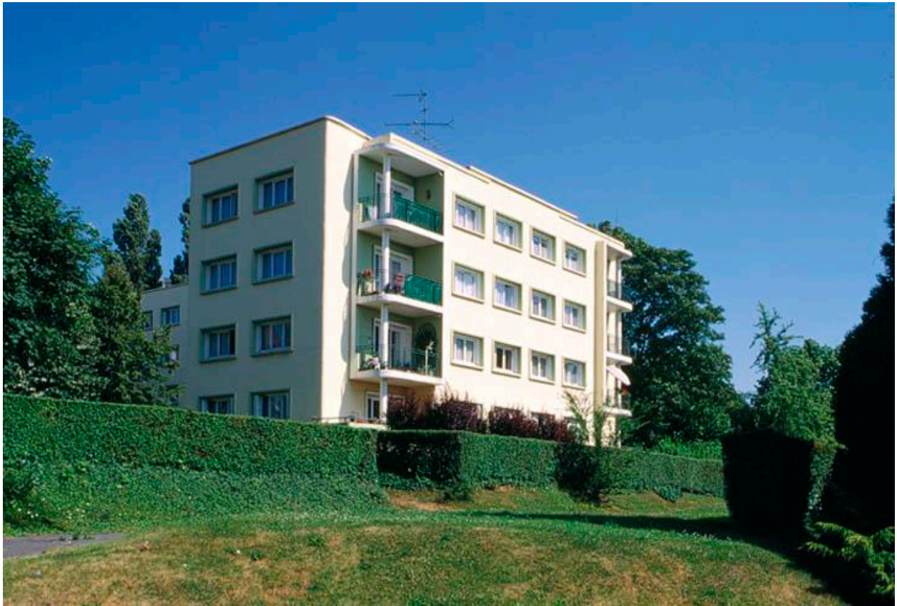
Vue générale de l'immeuble situé à droite du boulevard, élévation sud.
