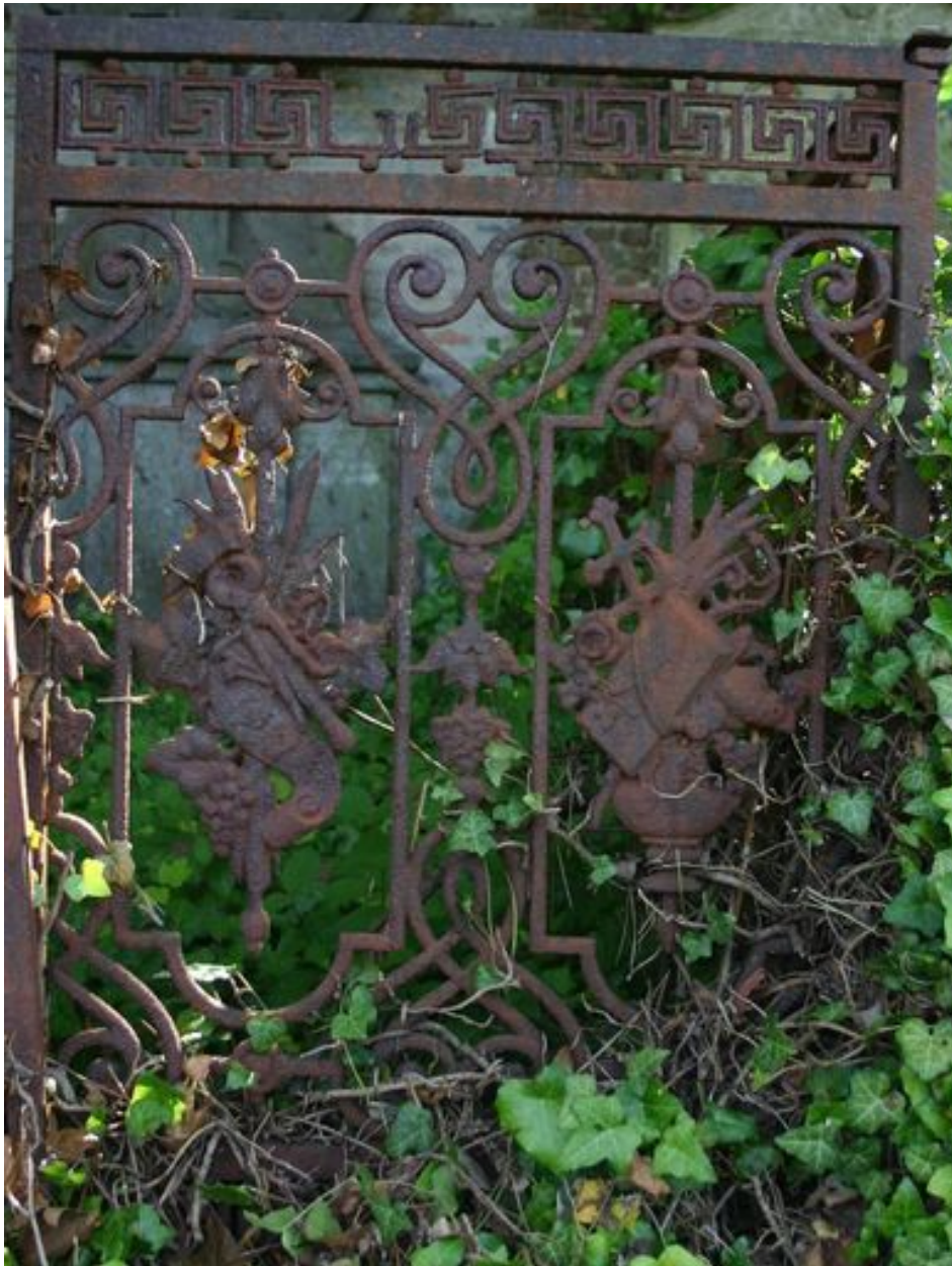
Vantail droit de la grille de clôture.
