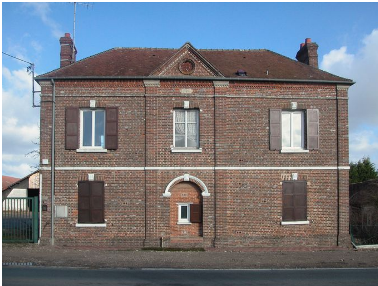
Le logement de directeur, façade sur rue.
