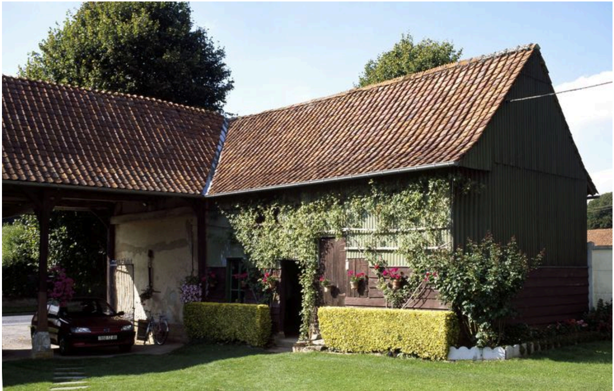
Vue du passage charretier et de la resserre depuis la cour.
