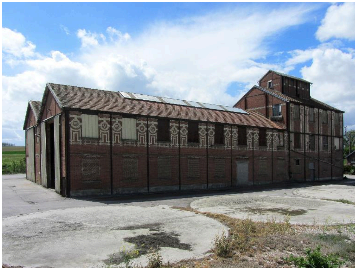
Vue d'ensemble de la façade nord de la râperie.
