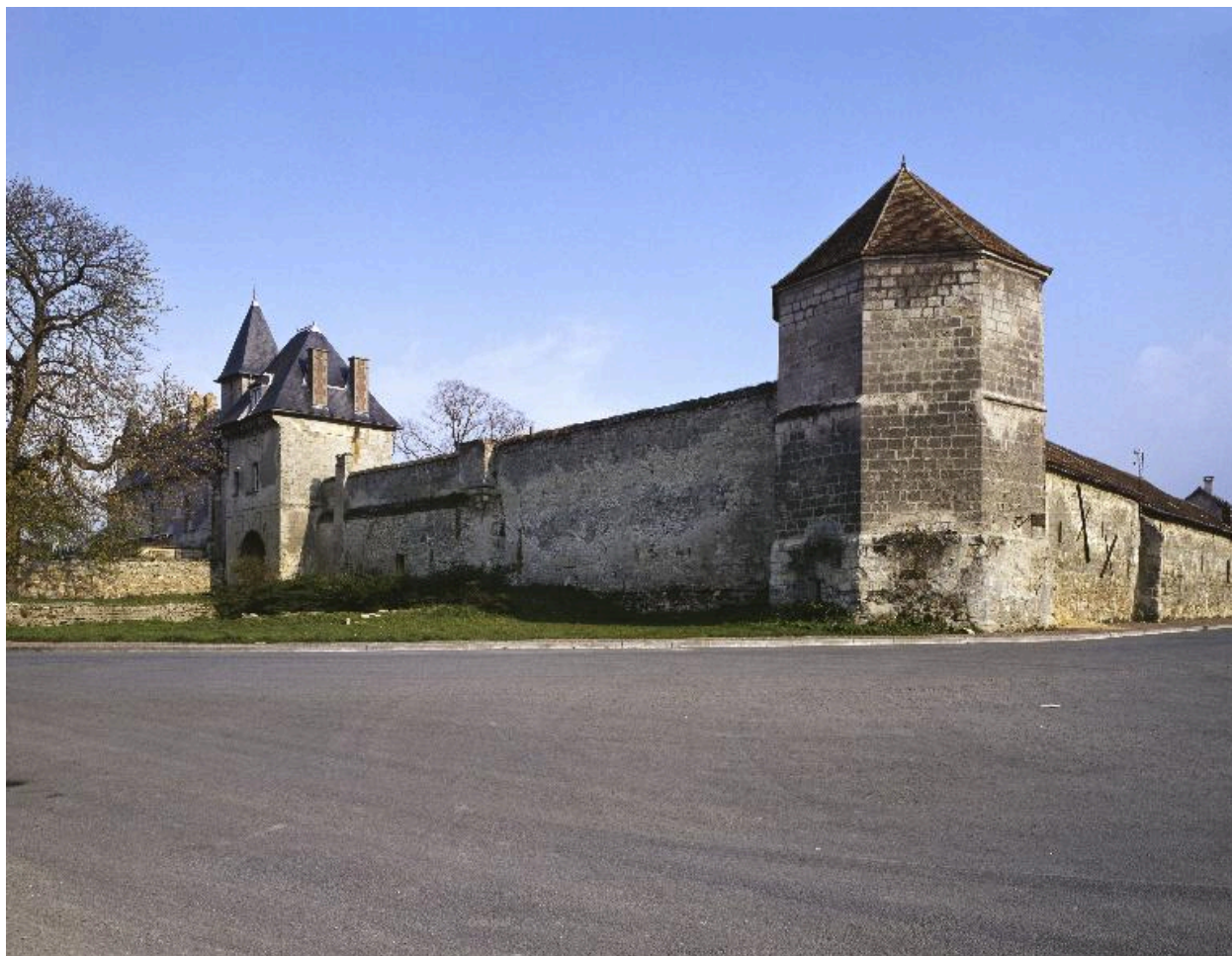
Vue d'ensemble du château et de son enceinte depuis l'ouest.
