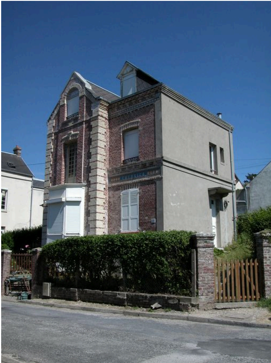
Vue de trois-quarts, avec la façade latérale droite enduite après 1945.
