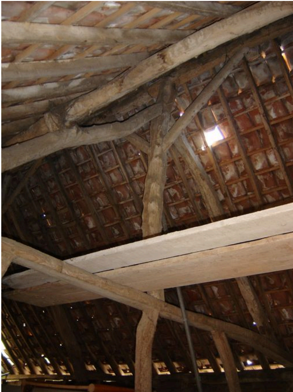
Autre vue d'une ferme de charpente.
