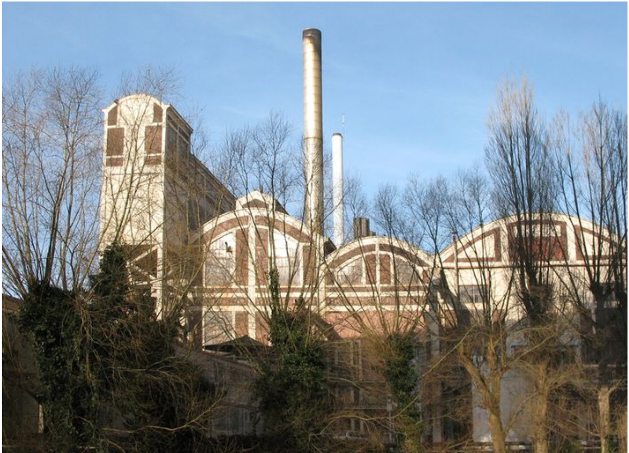
Elévation de la centrale vapeur, façade sud.
