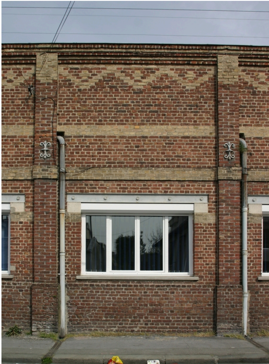
Détail d'une travée de l'atelier de broderie de 1912.
