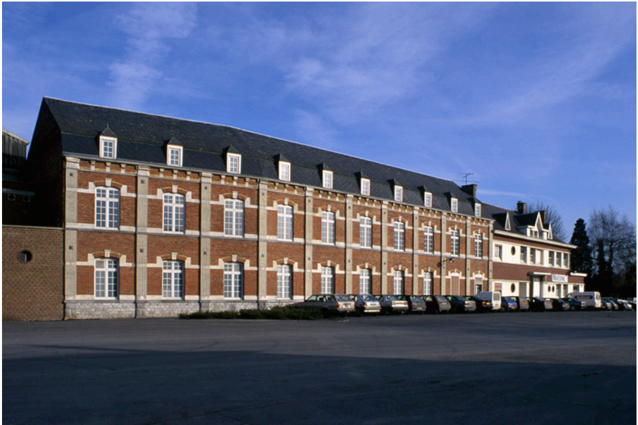
Façade de l'atelier de fabrication reconstruit vers 1922.
