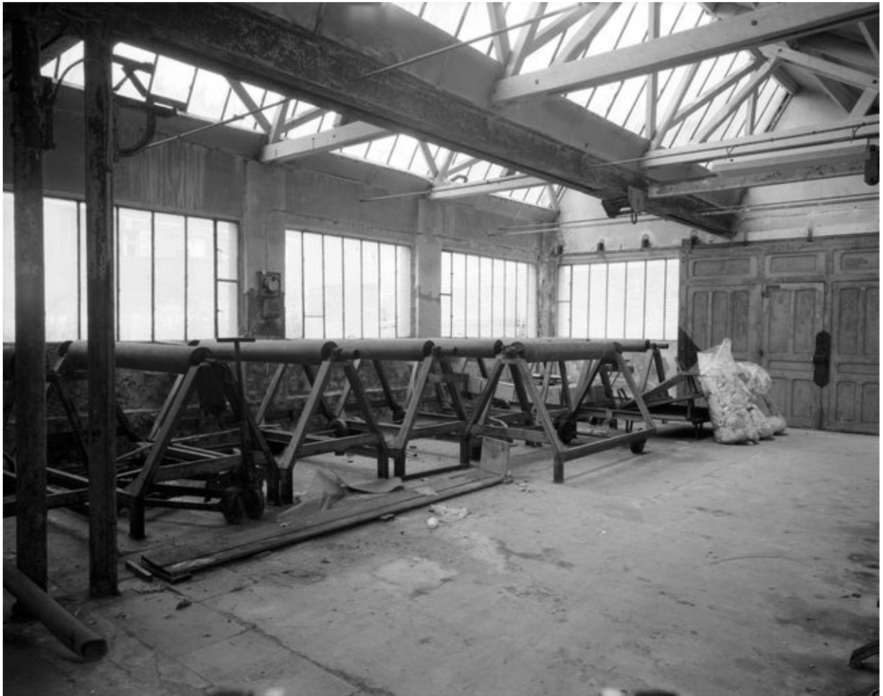
Vue intérieure des anciens ateliers de fabrication.
