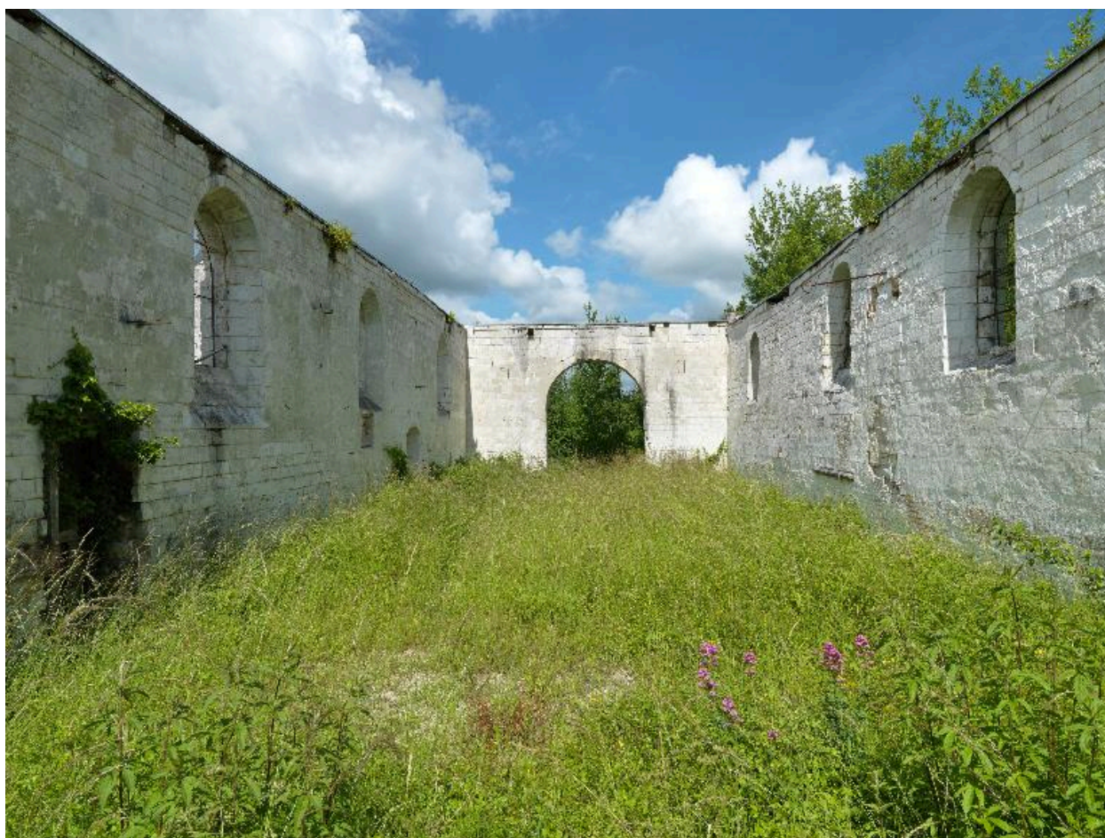
Vue intérieure du choeur de l'église paroissiale Saint-Jacques-le-Majeur.
