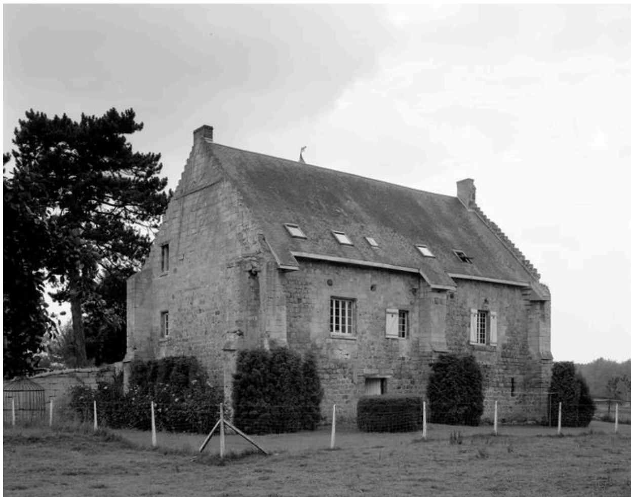
Logis. Elévation postérieure.
