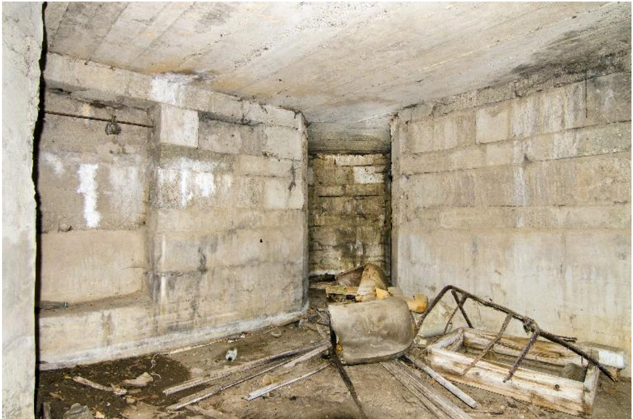
Vue intérieure, salle nord. En face, la tourelle nord
