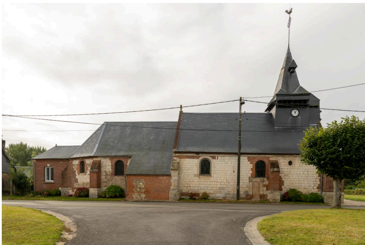
Vue depuis le nord.
