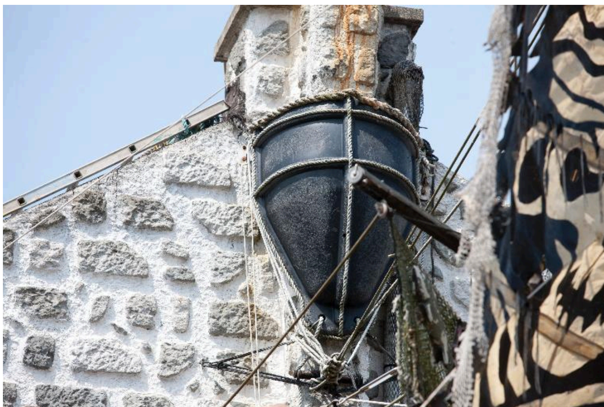
Vue partielle du pignon.
