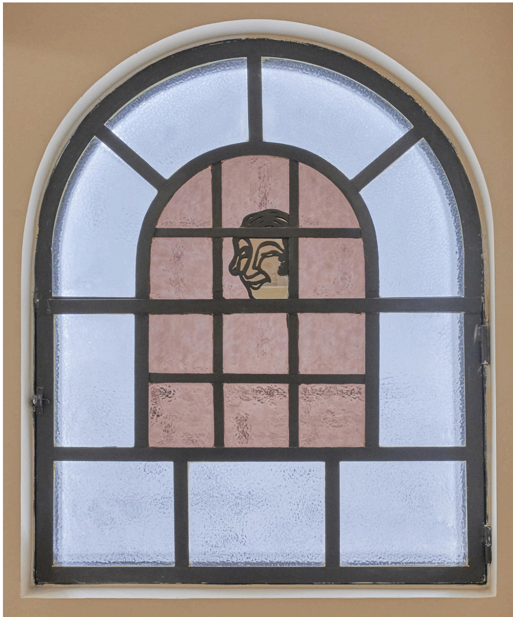
Verrière de la cage d'escalier.
