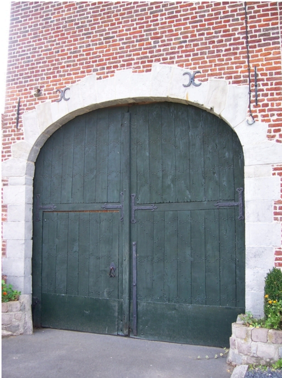
Porte charretière, 190 avenue du Général-Leclerc.
