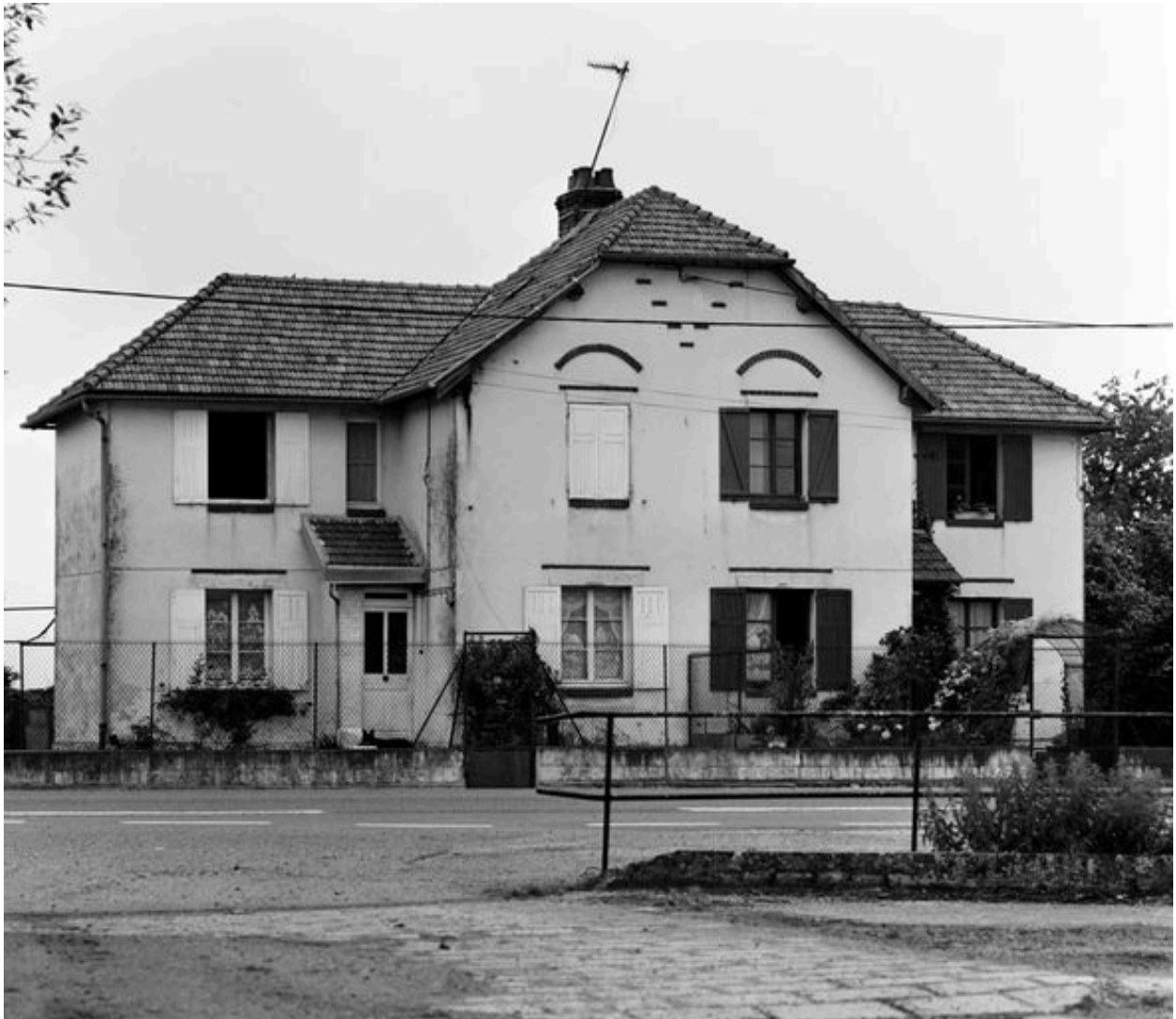
Logement d'ouvriers des années 1930 : façade est.
