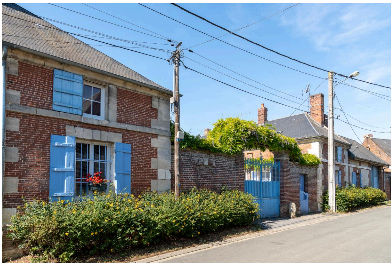
Maison n°4 rue Pauvrette, vue depuis le nord-ouest.
