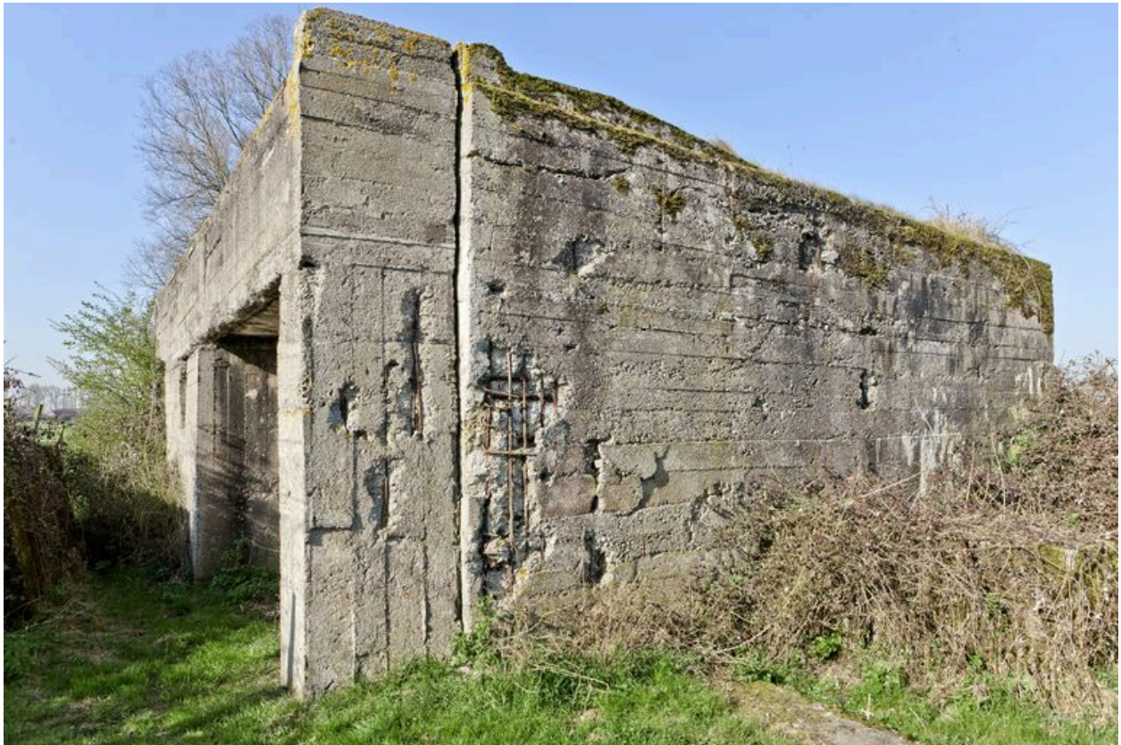
Vue générale vers le nord-ouest
