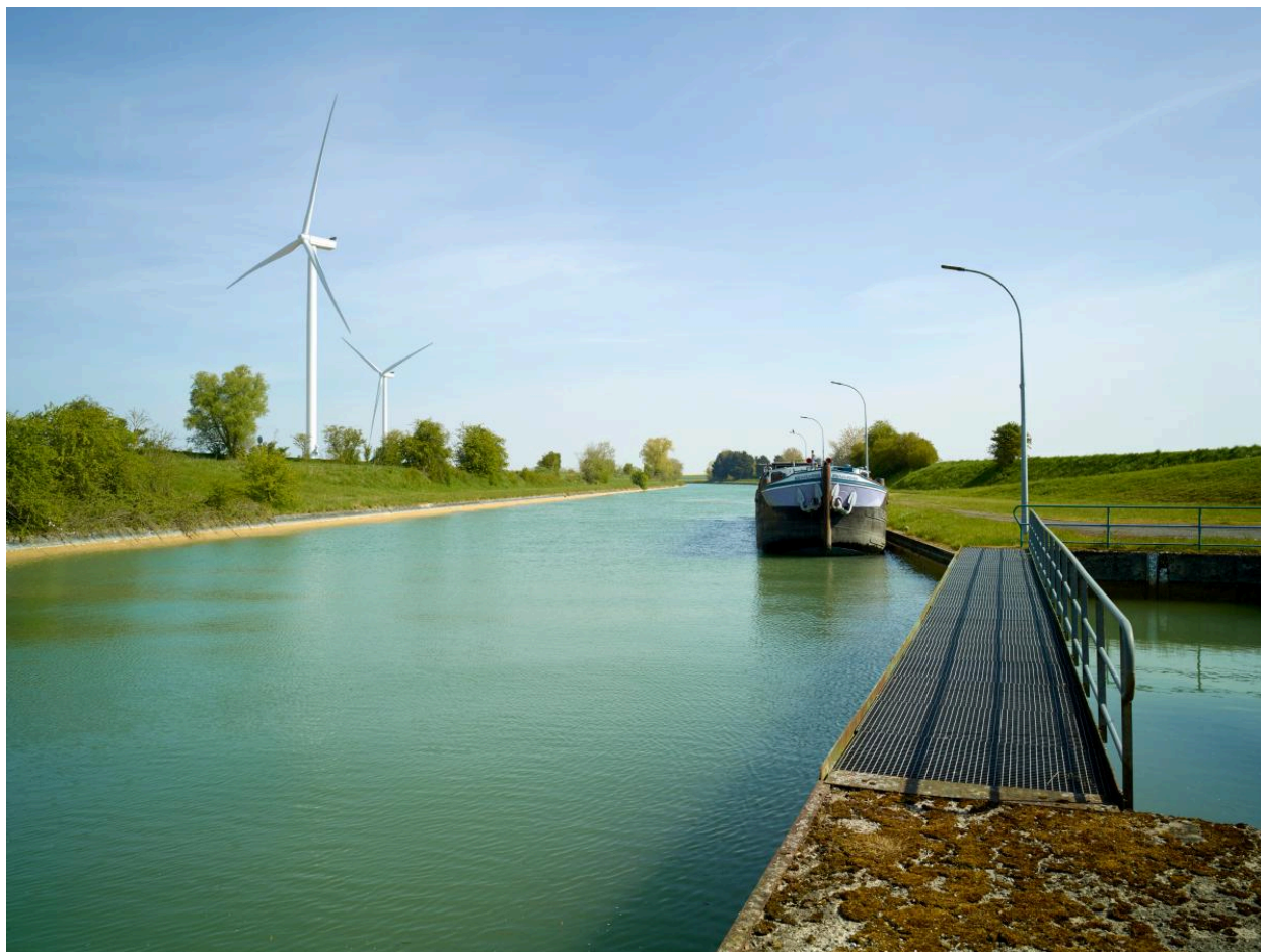
Aval du site d'écluse. Passerelle du bassin de tranquillisation, péniche stationnée.
