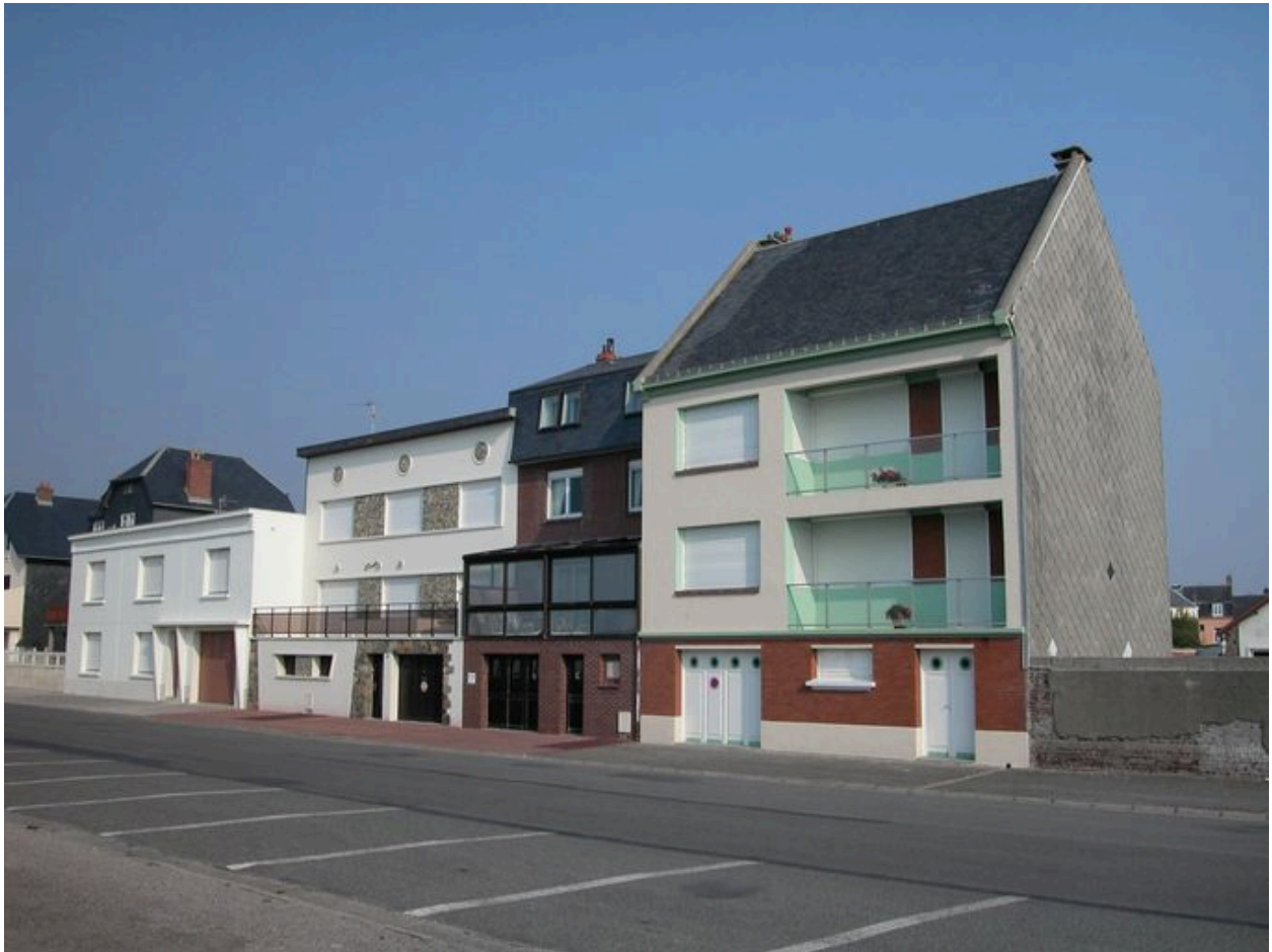
Constructions sur le front de mer.
