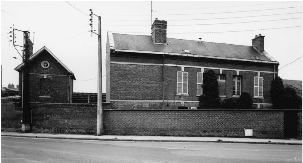
Le logement patronal et la conciergerie, vus depuis le nord.
