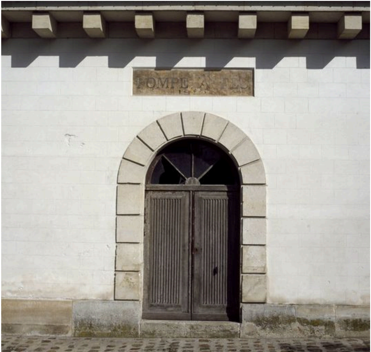
Façade antérieure, détail de l'entrée surmontée de l'inscription : Pompe à feu 1810.
