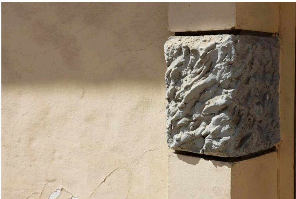
Maison, détail de la maçonnerie.
