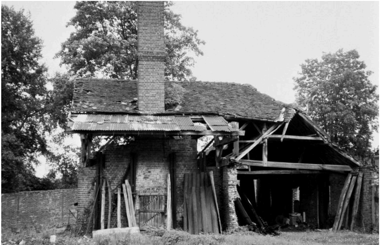
Le four de cuisson et sa cheminée carrée avant sa destruction (AP).
