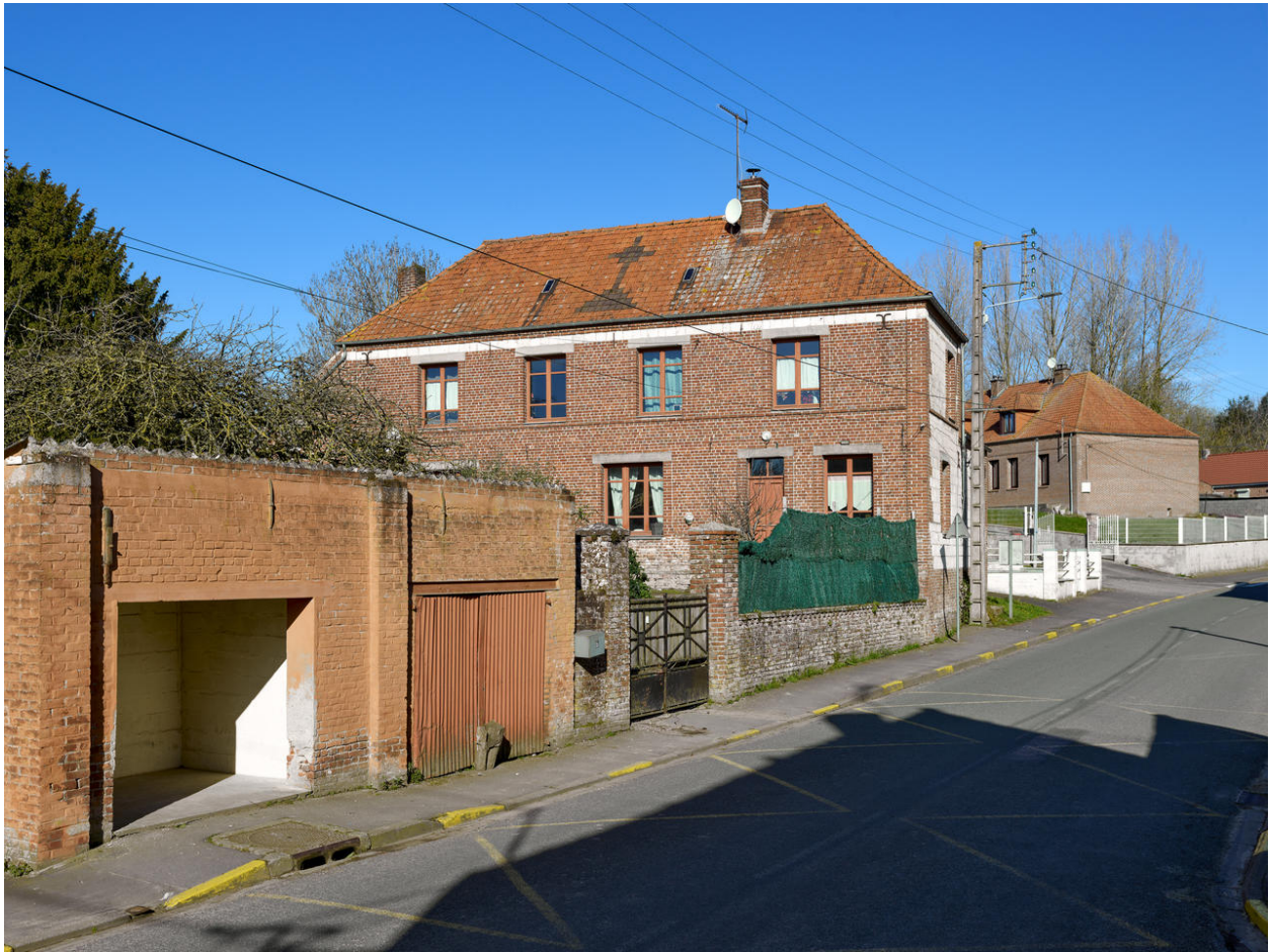
Vue de l'élévation sud.
