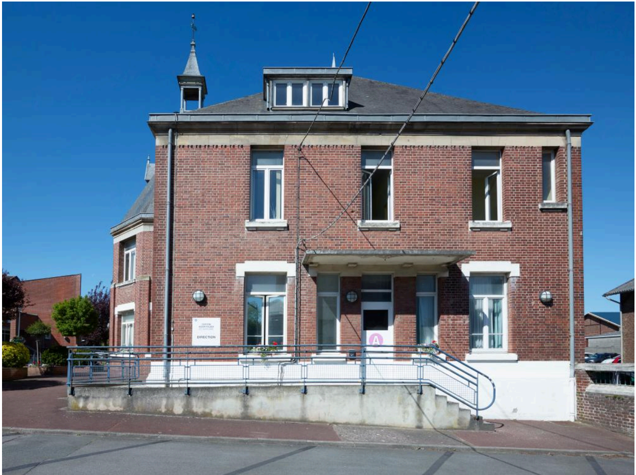
Ancien pavillon de l'administration : façade est longeant l'accès dans l'enceinte de l'hôpital.
