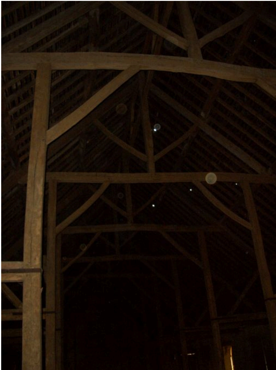
Vue partielle de la charpente des bouveries.
