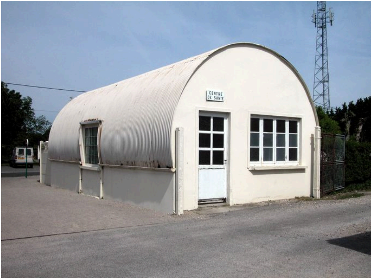
Le dispensaire, construction type de l'après-guerre.
