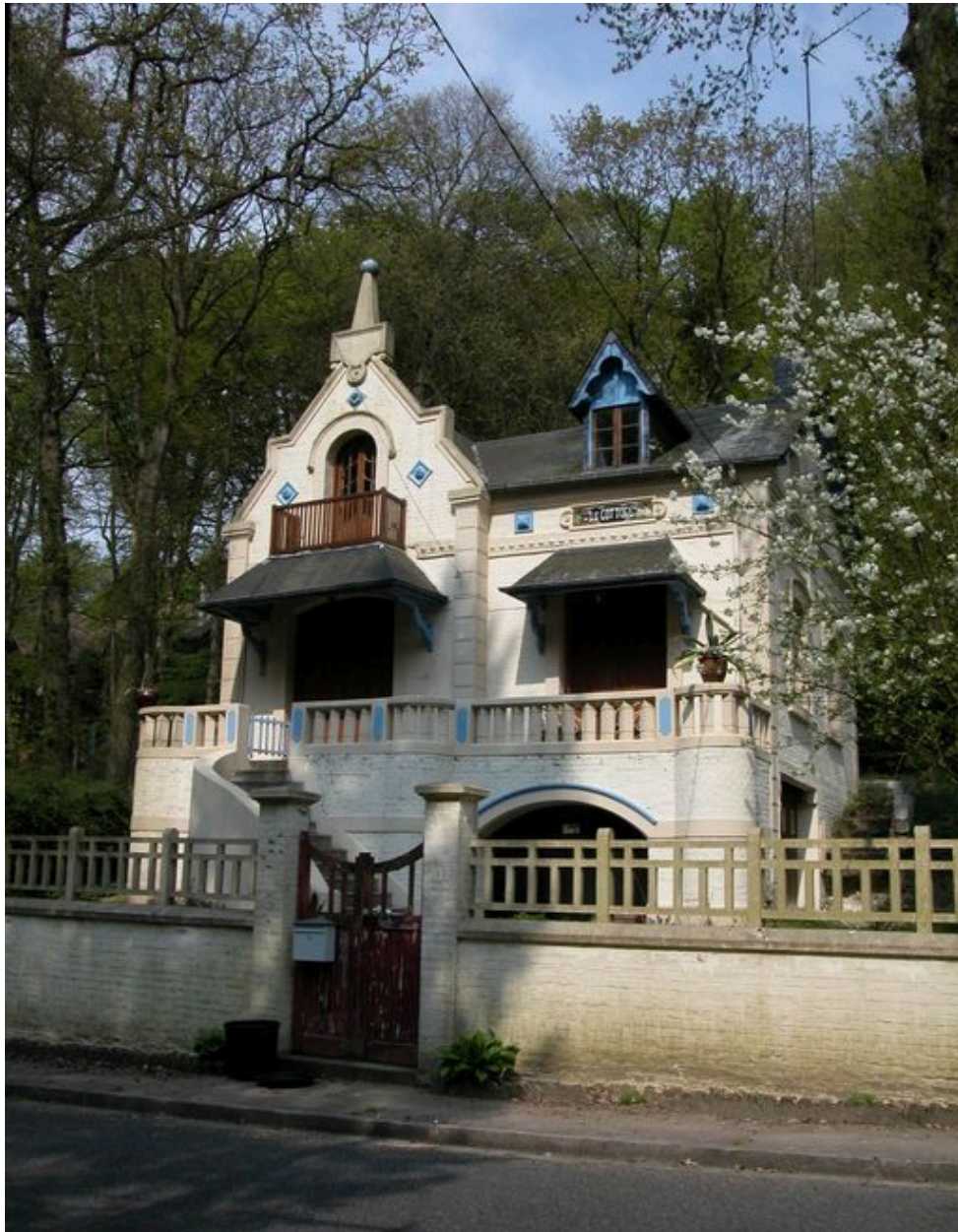
Vue de trois-quarts depuis la rue.
